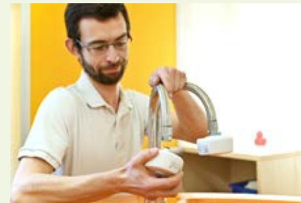
Christian Fischer aus dem Bereich Heizung/Sanitär beim Austausch eines Trinkwassersterilfilters im Kreißaal.
